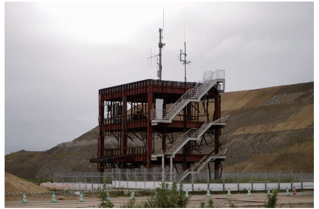
周囲を盛り土で囲まれる防災庁舎跡。2016年8月撮影。
